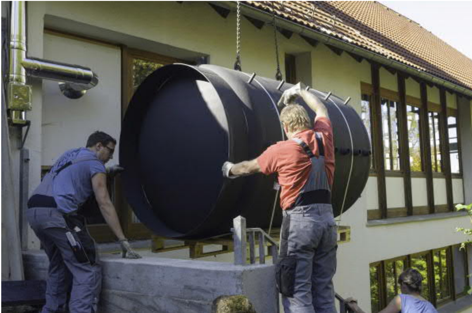
Der neue Wasserkessel kommt. Der Einbau ist Millimeterarbeit.
